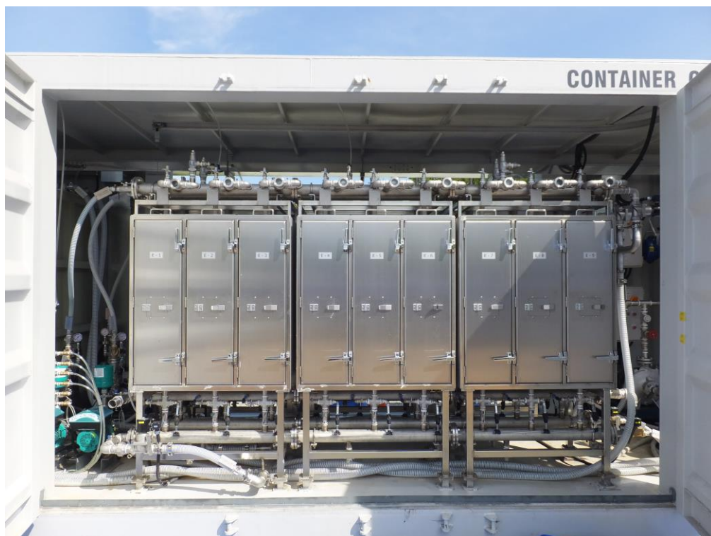
図3 カートリッジ交換方式の吸着設備
