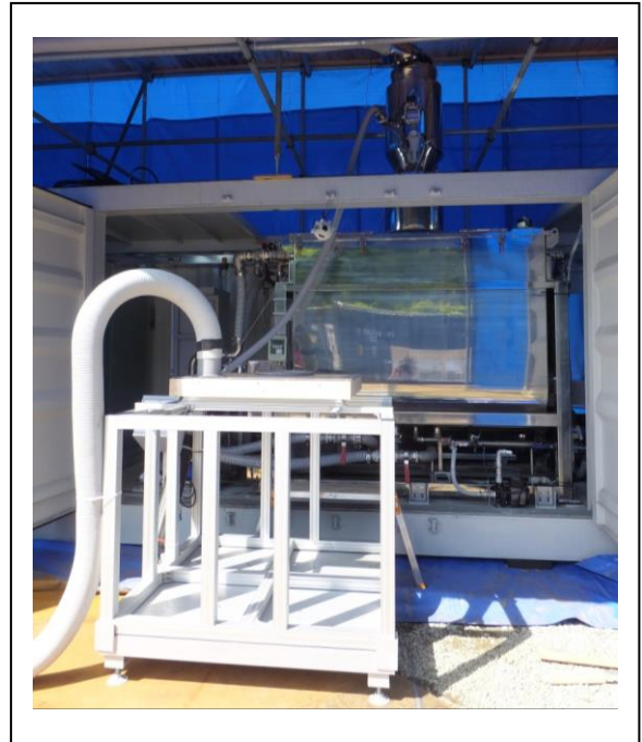
図2 専用容器からミキサーへの真空引き設備
